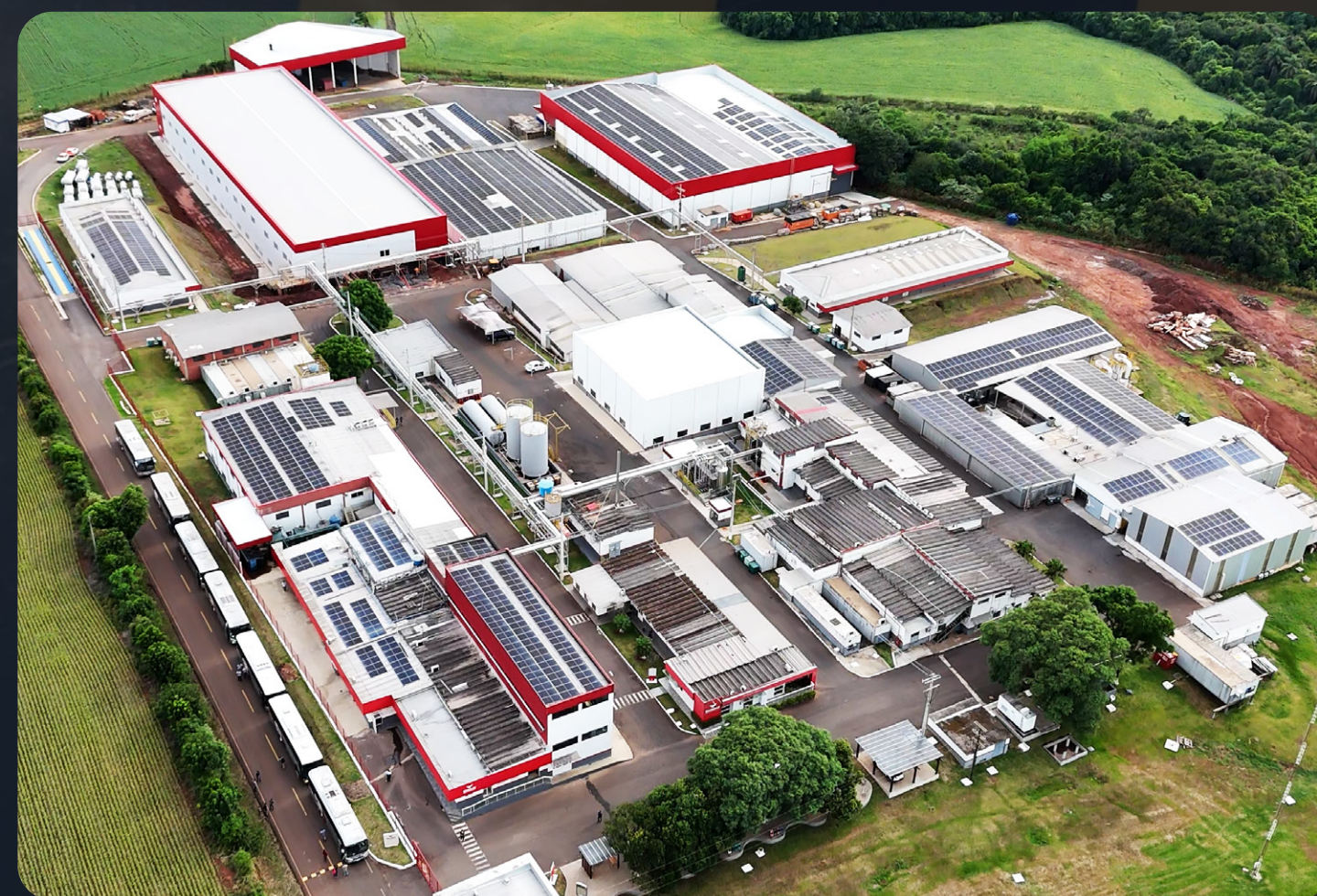
Painéis fotovoltaicos na fábrica da Simbiose
